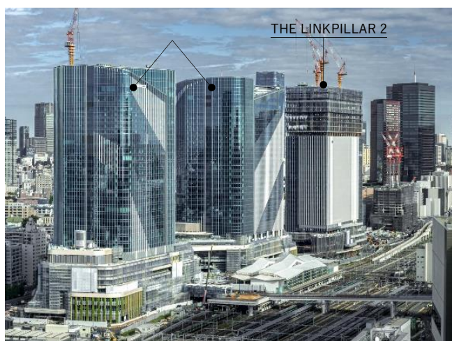
品川駅方面からみた TAKANAWA GATEWAY CITY (2024年10月撮影)
